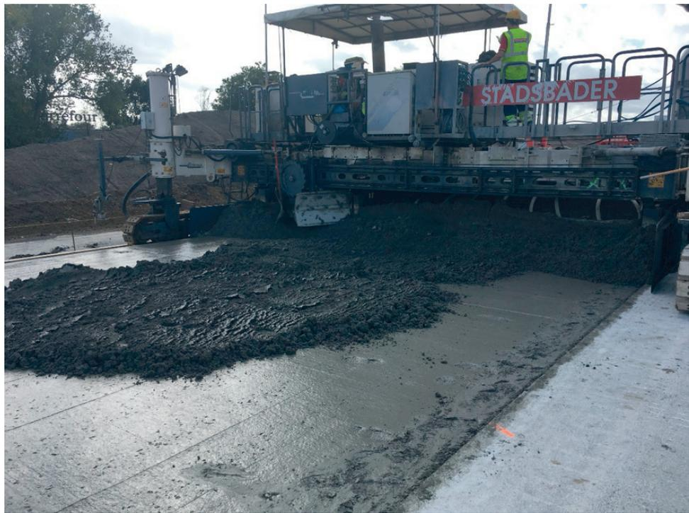
*Figura 5. Visita a Amberes con técnicos de la administración para estudiar la ejecución de pavimentos continuos de hormigón armado bicapas con textura de árido visto, solución proyectada en la A-33 en Murcia.*
