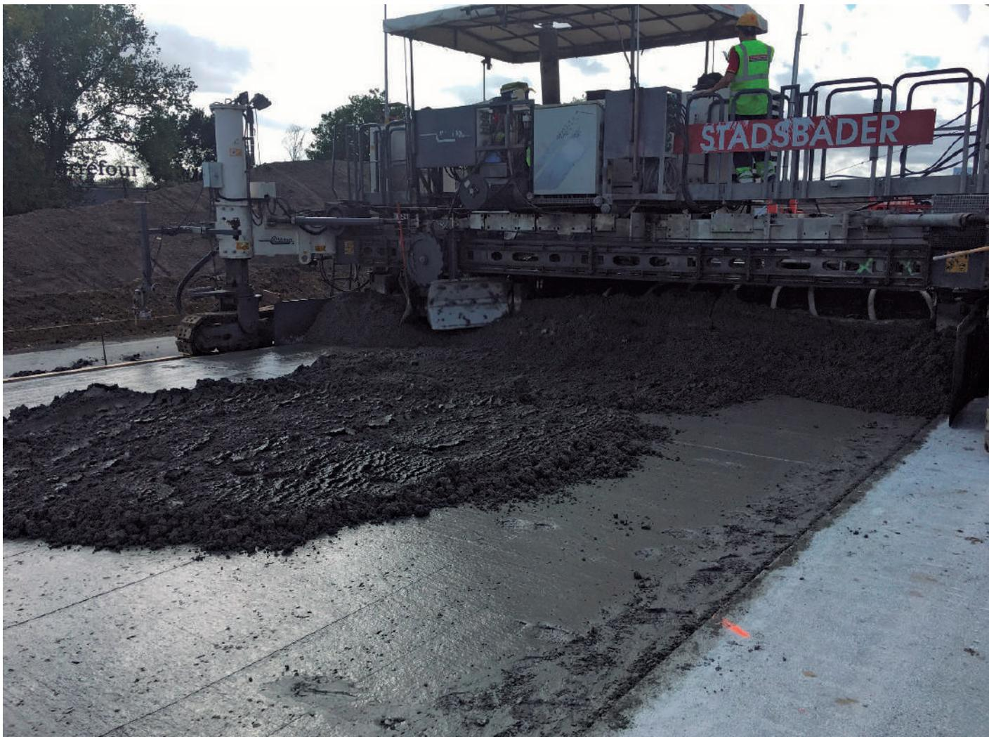
Figura 5. Visita a Amberes con técnicos de la administración para estudiar la ejecución de pavimentos continuos de hormigón armado bicapa con textura de árido visto, solución proyectada en el tramo Yecla-Caudete de la autovía A-33, entre Murcia y Albacete.
