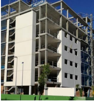
Edificio Monfragüe en Distrito de Villaverde en Madrid. TOUZA ARQUITECTOS. Fachada resuelta mediante paneles prefabricados de hormigón arquitectónico de color blanco y textura lisa de PREFABRICADOS HERMANOS QUIJADA
