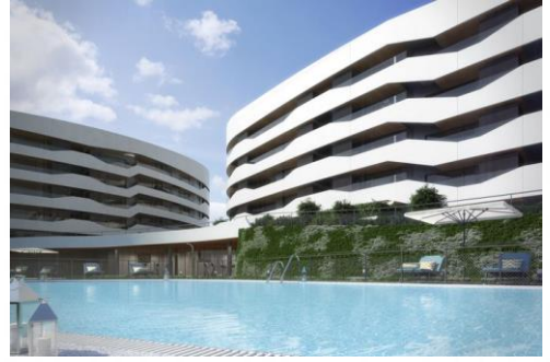
Edificio Atria Homes en Alcobendas (Madrid). CANO Y ESCARIO ARQUITECTURA. Fachadas realizadas con paneles prefabricados de GRC tipo sándwich de PREHORQUISA
