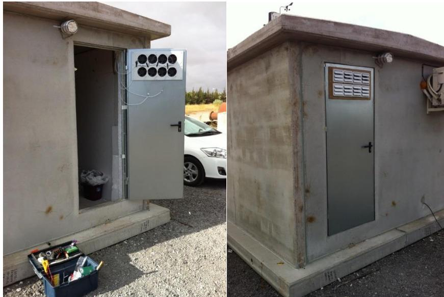
*figura 21. Ventiladores instalados a manera de extractores en la puerta de la caseta*
