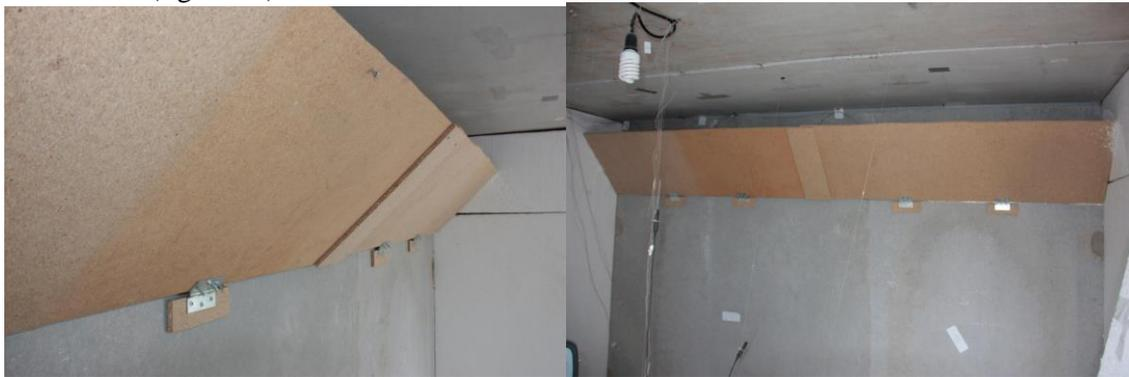
figura 23. Deflector para forzar el aire hacia el techo de la caseta
