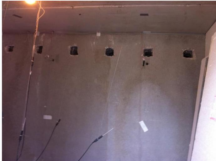
figura 22. Orificios de ventilación para permitir la ventilación nocturna
