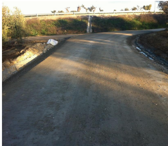
Proyecto de tramo de camino rural estabilizado. Mairena del Aljarafe (Sevilla)
