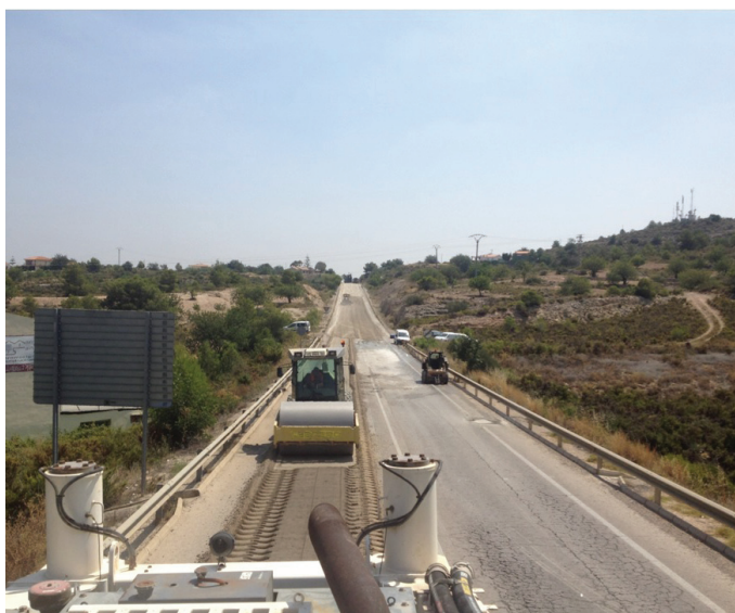
Reciclado del firme in situ con cemento. Ctra CV-37 Variante de Ribarroja (Diputación de Valencia)
