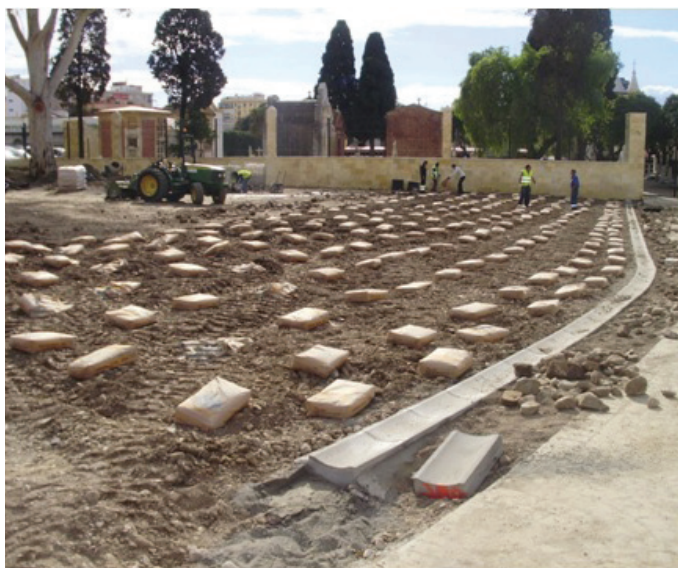
Suelos estabilizados para rodadura de plaza pública (Ayuntamiento de Málaga)
