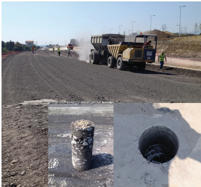
Estabilización de suelo. Variante UPV. Diputación Foral de Vizcaya
