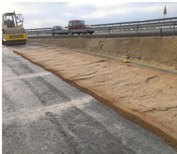
Accesos al puente sobre la bahía de Cádiz
