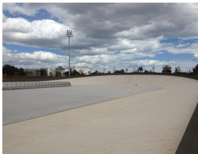
Construcción del pavimento de hormigón del velódromo de San Vicente del Raspeig (Valencia)
